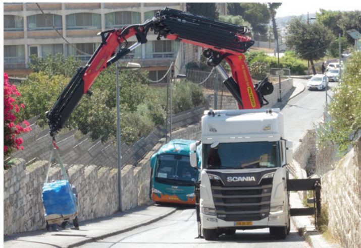
Camion grue livrant les pierres par dessus le mur de clôture du monastère
